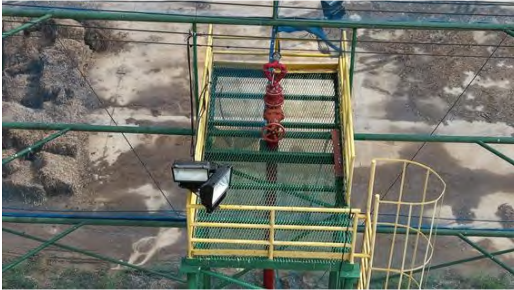
รูปที่ 2.10.2-2 แท่นปืนฉีดน้ำดับเพลิง (Monitor Gun Turret)
